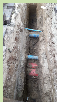
Een proefsleuf ter hoogte van Bank & Co
