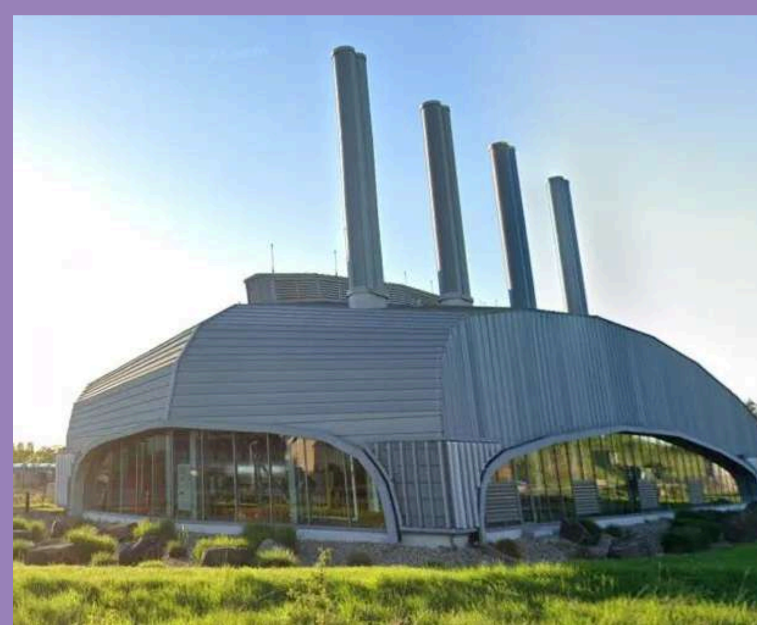
Warmtecentrale in de wijk (ca. 10 x 15 m)
