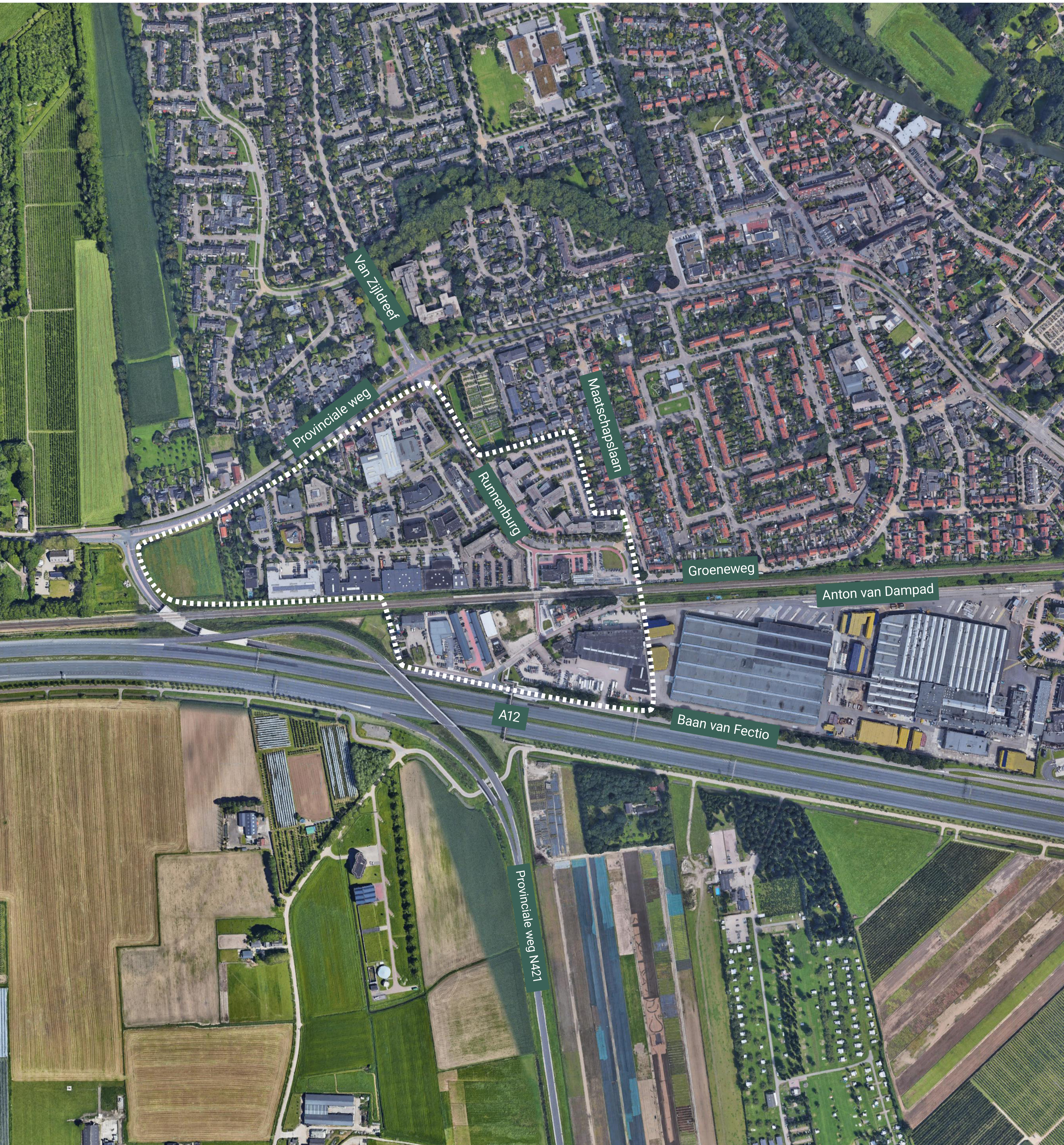
Luchtfoto van de huidige situatie, met het plangebied
