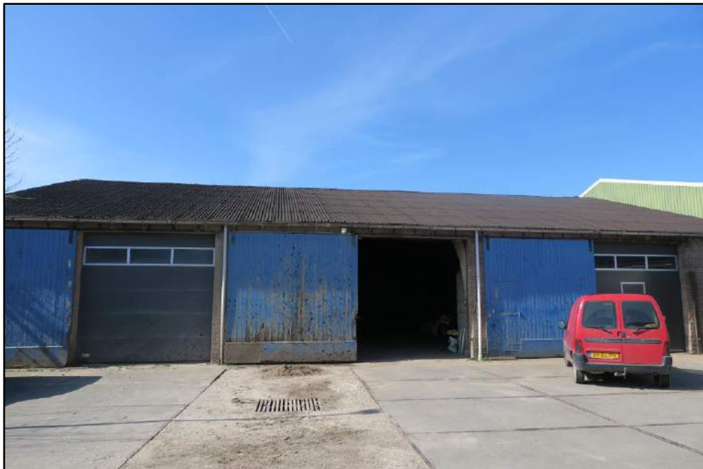
Figuur 2 Gebouw B, een loods bestaande uit gemetselde muren en een golfplaten dak.
