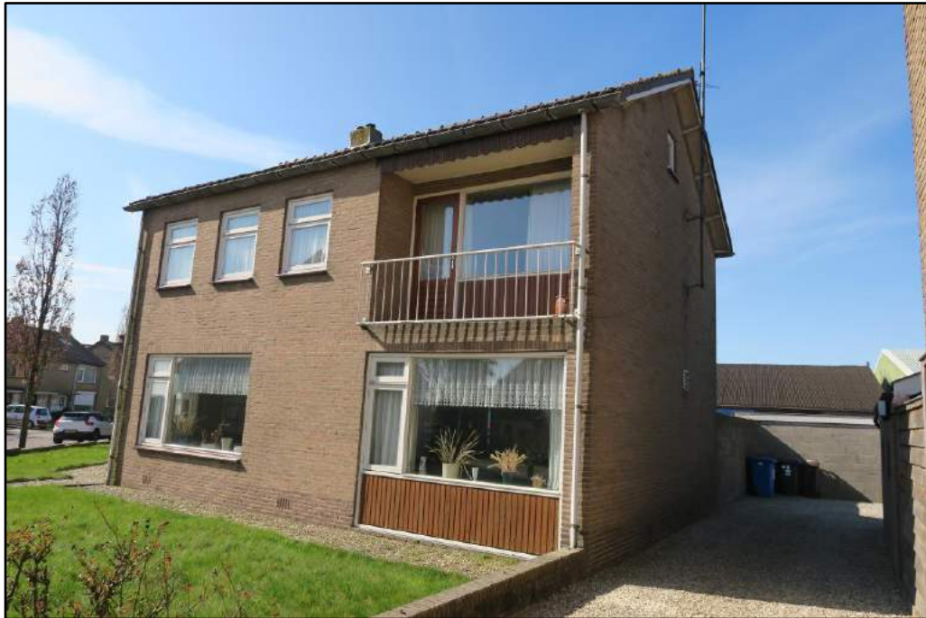
Figuur 1 De planlocatie is gelegen aan de Herenstraat 44 te Werkhoven en bestaat uit een woonhuis (A) met twee loodsen en een gebouw met garages.
